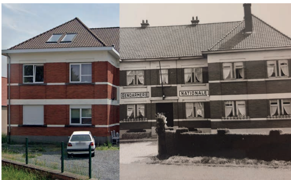
Brigade de Velaines, à Celles en Hainaut, construite en 1939. Elle est expropriée par arrêté ministériel le 30 juin 2009 et est transformée en appartements. Source : Bruxelles, AGR, Dossiers de Brigades de Gendarmerie, n° 2311.
